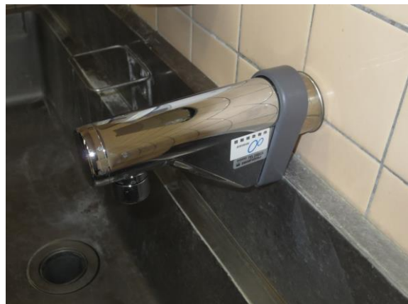
障害福祉サービス事業所ひまわり 自動水栓工事完了
