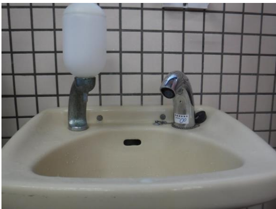
ひまわり自立支援センター 自動水栓工事完了
